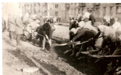
Старшеклассники работают по закладке трамвайных путей по ул. Дружбы.
